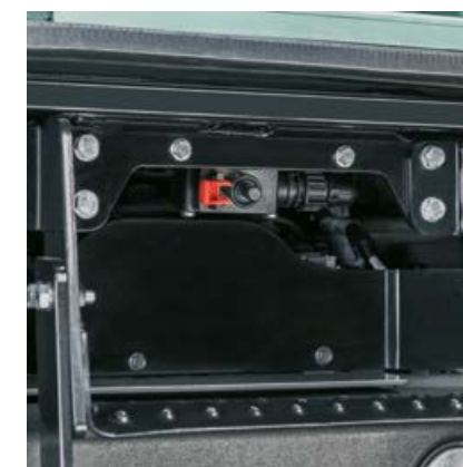
Le coupe-batterie est installé à portée de main au niveau du marchepied gauche.
